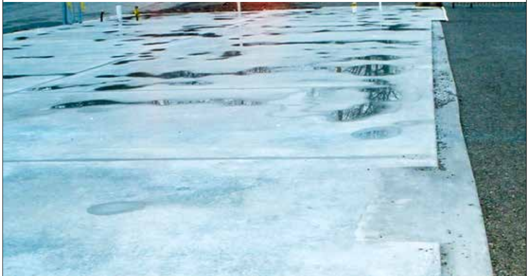
An ADA unit once poured.
